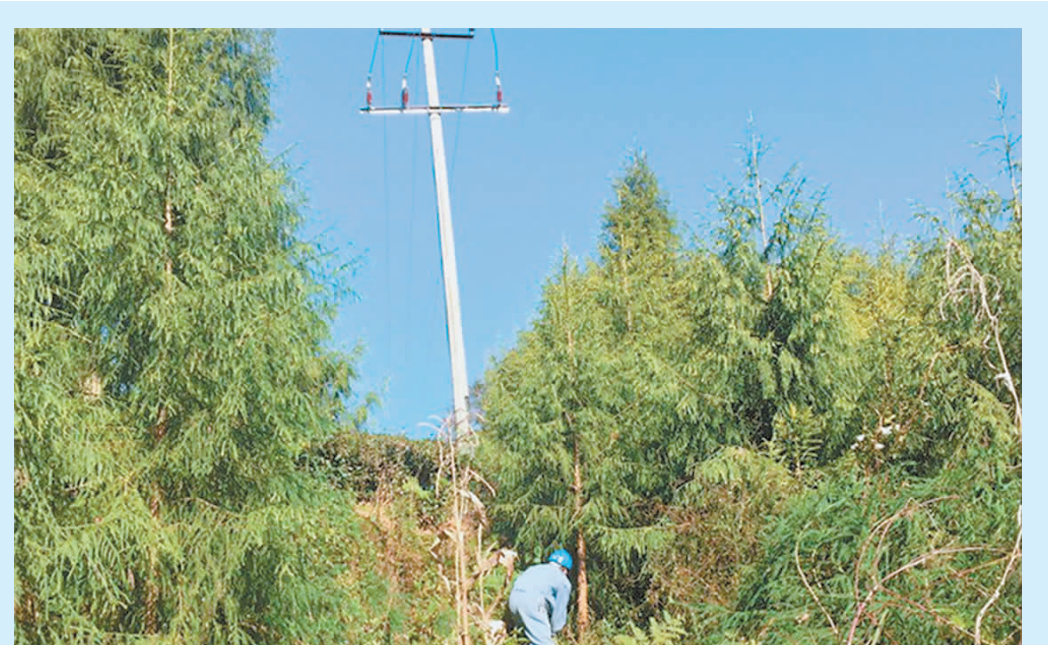
芒市平山供电所开展线路清障工作。为确保平山乡冬季可靠供电,平山供电所近日对10千伏平杞线平蛮支线104至130号杆巡视及清障。从主线路到分支线路,对所有线路通道附近有可能造成竹木搭接线路的区域进行了清除维护,确保了辖区电力供应正常,得到了用户的一致好评。(通讯员 李根建 摄影报道)
